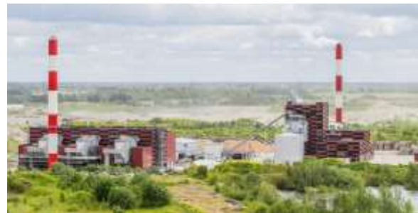
Figure 45 – Centrale électrique Tallinna Elektriijaam (Source : OÜ Utilitas Tallinna Elektriijaam)
