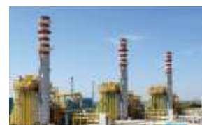
Figure 106 – Centrale Enipower à Brindisi (Source : Enipower)
