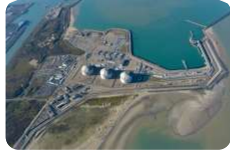
Figure 18 – Terminal méthanier de Dunkerque (Source : EDF)
